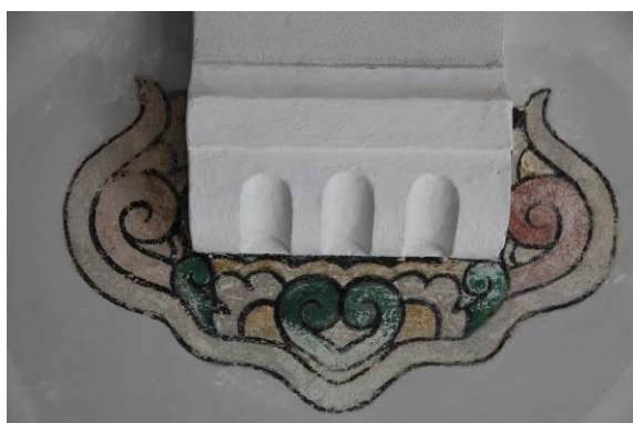
Nord "4", efter afdækning
