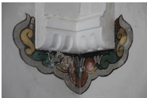
Hjørne sydvest, efter afdækning, mørtel-reparationer, under retouchering
