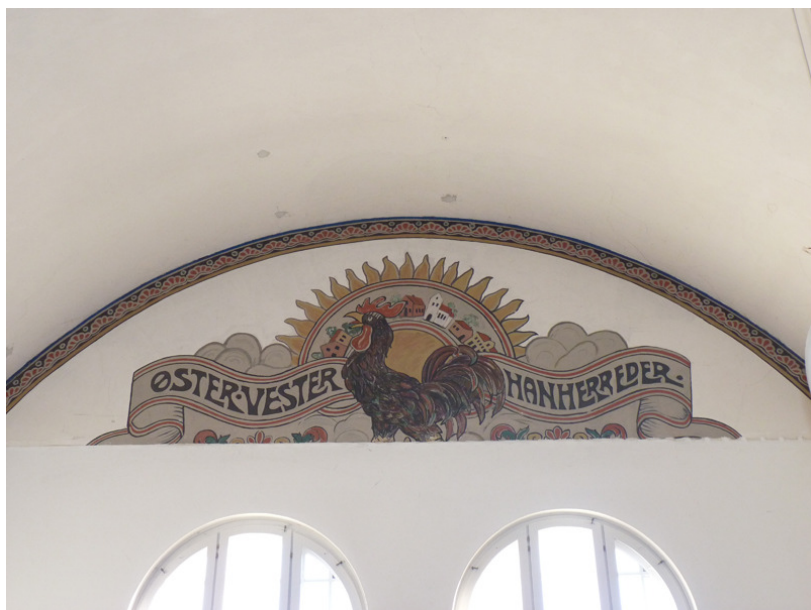
Dekoration på østvæg før behandling. Dekorationen er halvt overmalet med de hårdt bundne malingslag.
