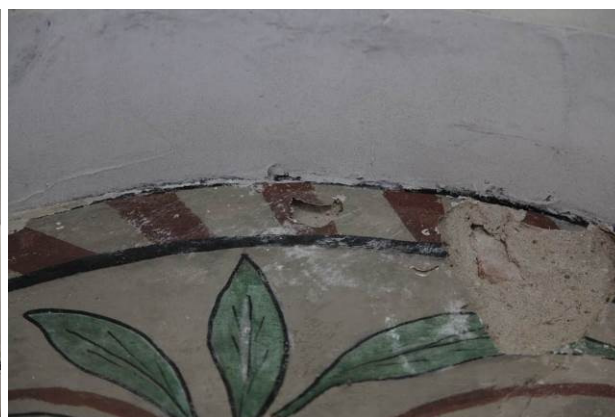
Blomsterdecoration i halvcirkelbuen på vestvæggen før behandling og detalje af skadesbillede
