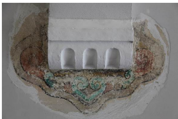
Nord "1", efter afdækning
