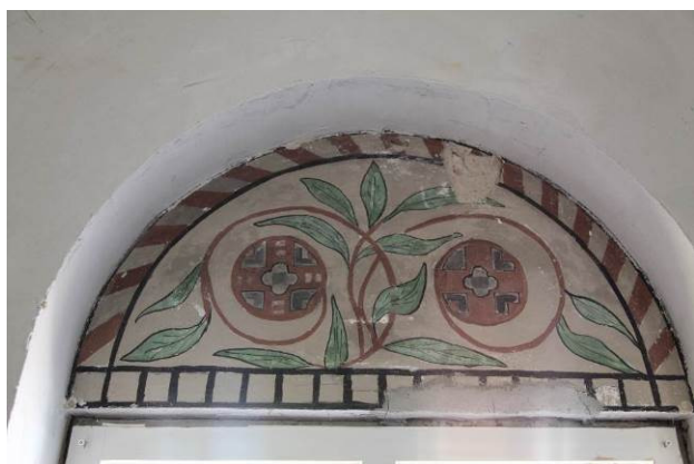
Blomsterdecoration i halvcirkelbuen på vestvæggen før behandling og detalje af skadesbillede
