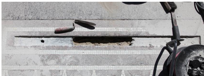
Mosaikstifter i dekorationsfelt mod trappe fjernet. Hullet i midten udvidet for tilførsel af mørtel/beton.
