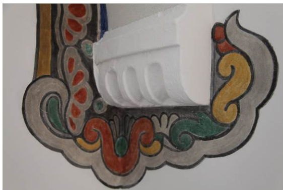
Hjørne sydøst, efter rekonstruktion
